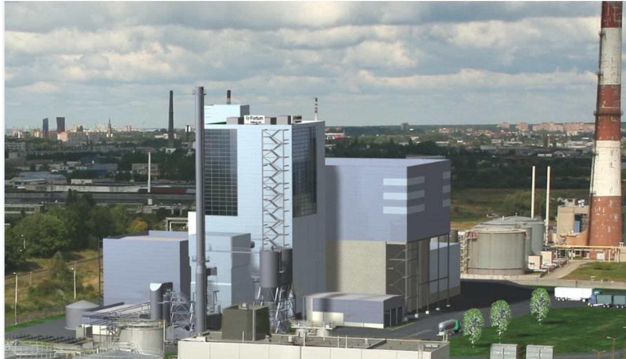
10.1 pav. Klaipėdos termofikacinės jėgainės bendras vaizdas
